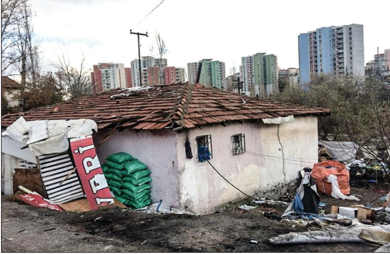
Şekil 10. Güzelyurt Mahallesi'nde (Keçiören) bir atık emekçisinin evi. Fotoğraf: Saitcan Güngördü, 2020.
