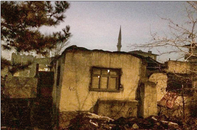
Şekil 11. Ulubey Mahallesi'nde (Altındağ) bir atık emekçisinin evi. Fotoğraf: Saitcan Güngördü, 2020.
