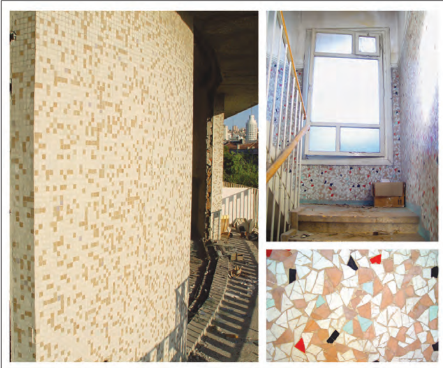
Şekil 4. Übeyde Elli Apartmanı'nın dış cephe ve kat hollerindeki mozaikler. Kaynak: Elli Ailesi Arşivi.
