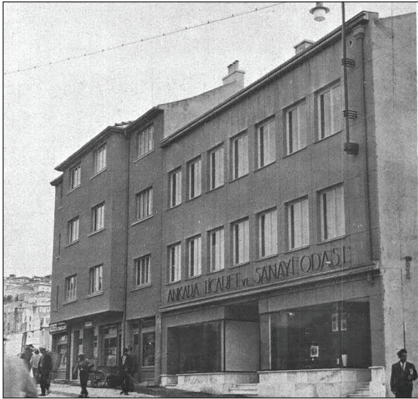
Şekil 25. Posta Caddesi 28 numaradaki eski Ankara Ticaret ve Sanayi Odası binası.
