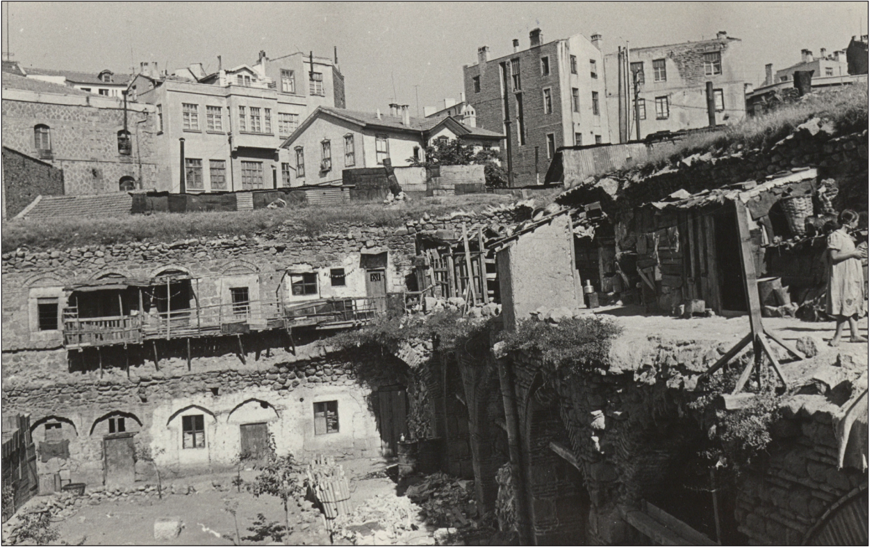
Şekil 27. Yangın ve yıkım sonrası-Onarım öncesi Sulu Han ve etrafında barınan yoksullar.
