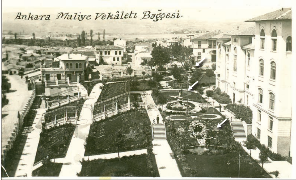
Şekil 3. Maliye Bakanlığı havuzlarının birarada görünüşü, 1930'lar. Kaynak: VEKAM Kütüphanesi ve Arşivi, Envanter No: 0955.
