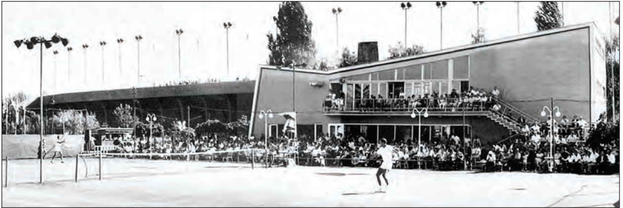
Şekil 5. Ankara Tenis Kulübü yapısı.
