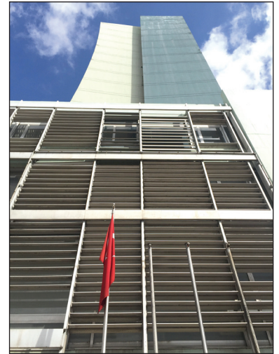
Şekil 15. Lale Sitesi (Akün Sahnesi) Atatürk Bulvarı cephesi giriş ve güneş kırıcı paneller. Fotoğraf: Funda Uz, 2018.
