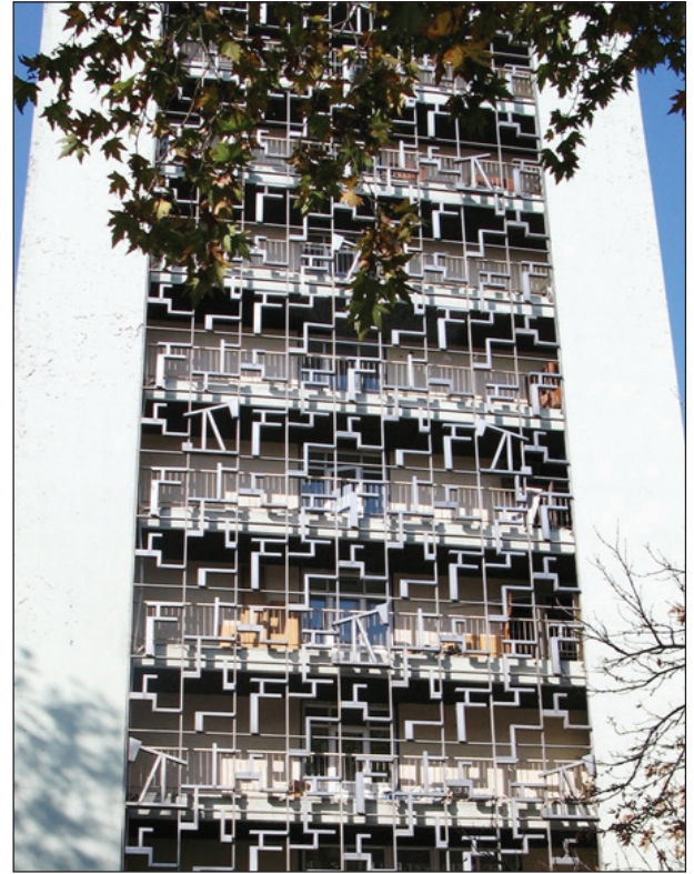
Şekil 5. TPAO Kurumsal kimliğini taşıyan alüminyum cephe. Kaynak: Baron Von Plastik, 2012.
