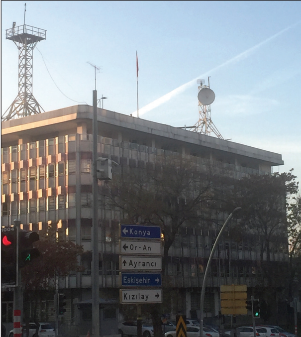
Şekil 17. TRT Ek Binası alüminyum ve pleksiglas güneş kırıcılar. Fotoğraf: Funda Uz, 2018.
