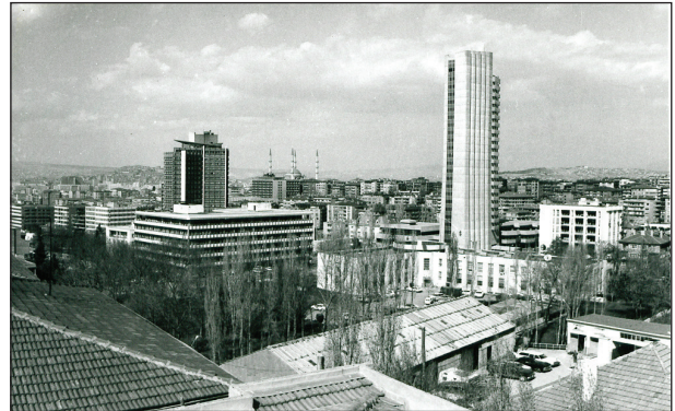
Şekil 18. TRT Ek Binası, ABD Büyükelçiliği, İş Bankası Genel Müdürlüğü ve Ankara Oteli. Kaynak: VEKAM Kütüphanesi ve Arşivi, Envanter no. 1822.
