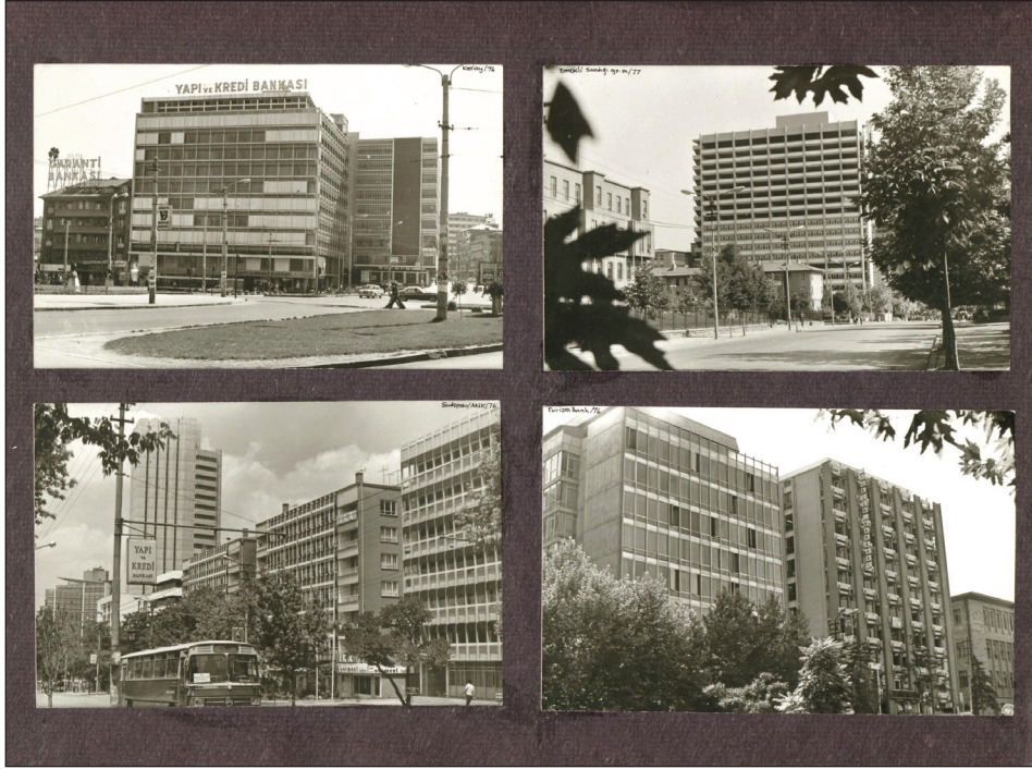
Şekil 9. Atatürk Bulvarı’nda binalarda güneş kırıcılar, 1976. Kaynak: SALT Araştırma, No: AHTURAL009.
