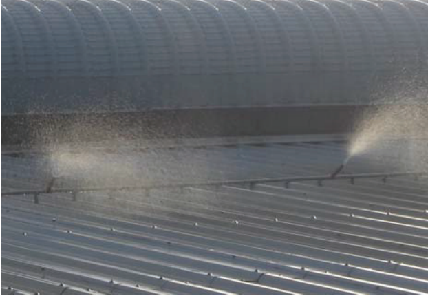
Resim 1. Çatının su sıkılarak soğutulması.
