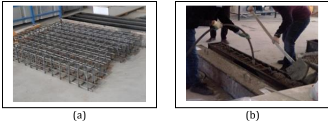
Şekil 3. Büyük ölçekli betonarme kiriş numuneleri hazırlanması. (a): donatı teşkili, (b): Beton dökümü.
