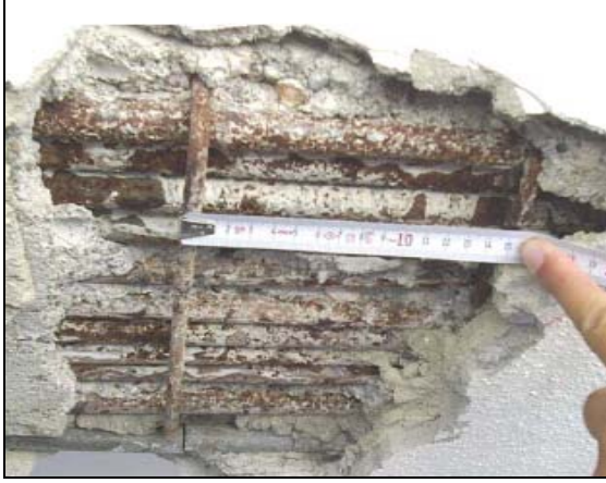
b) Datça Hükümet Konağı C Bloкта Kiriş altı donatıları (Kaplan ve ark., 2004c).
