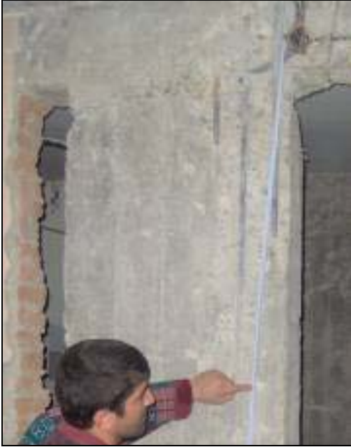
Şekil 11. Denizli Devlet Hastanesi binasında 160 cm etriye aralığı (Kaplan ve ark., 2003).
