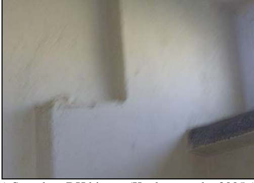
a) Sarayköy DH binası, (Kaplan ve ark., 2005g).
