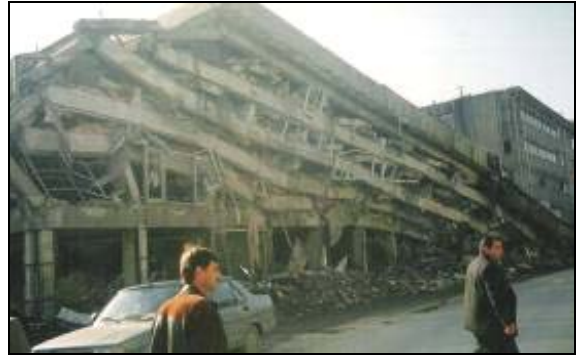
Şekil 1. 17.8.1999 Kocaeli depreminde yıkılan Bolu Defterdarlık binası.
