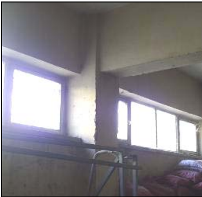
Şekil 19. Denizli, Sevil Kaynak İÖO binasında kısa kolon uygulaması (Kaplan ve ark., 2005f).
