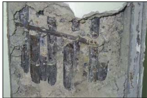
a) Denizli Eski SSK Hastane binasında kolon donatıları, (Kaplan ve ark., 2006a).
