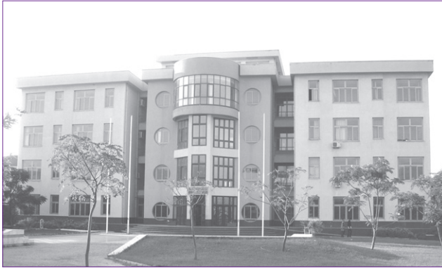
Şekil 2. Ege Üniversitesi İnşaat Mühendisliği Bölümü binası.
