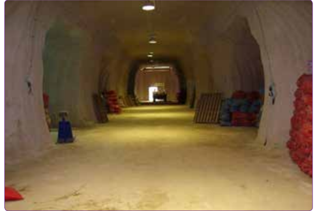
Şekil 10. Avanos'da yeraltı patates deposu. 43
