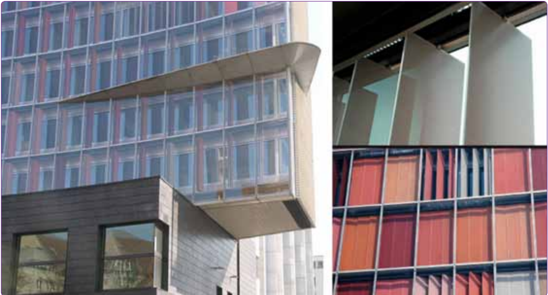
Şekil 8. Çok katlı çift cidarlı panjurlu cephe. [7]
