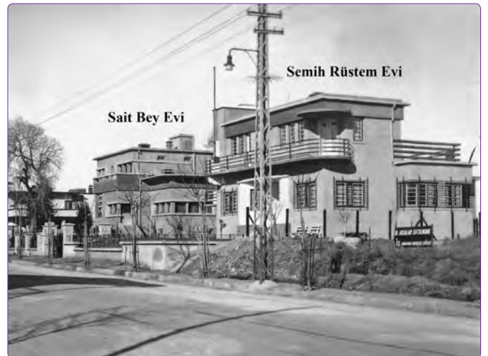
Şekil 18. Sait Bey Evi ve Semih Rüstem Evi'nin 1940'lara ait fotoğrafı (Adana Büyükşehir Belediyesi, s. 164).
