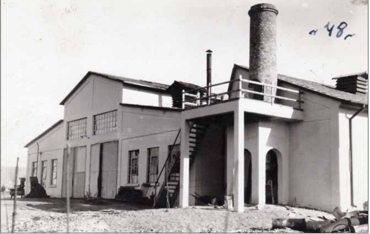
Şekil 22. Pulluk Fabrikası olarak kurulan atölye binası, 1928 (Bacası gözükten bölüm döküm atölyesi, sol taraf pulluk imalat atölyesi ve tamirhanedir.)
